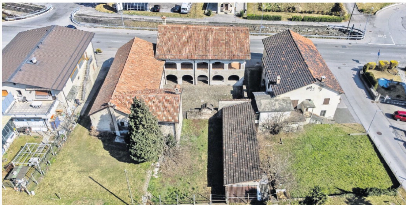
L'area da ristrutturare e trasformare.
